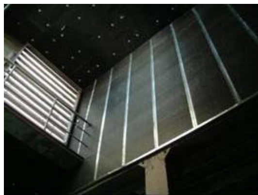
Figura 9 – Alterações no interior da conduta de ventilação
