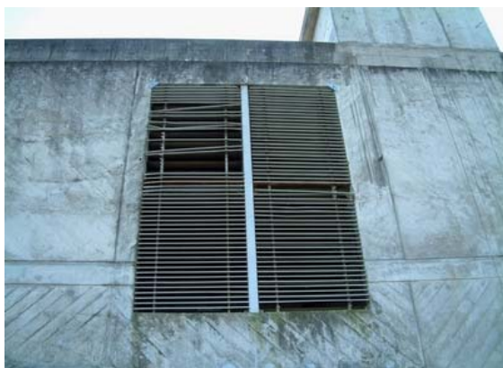
Figura 1 – Fotografia da parede traseira, onde se pode ver uma das entradas de ar
