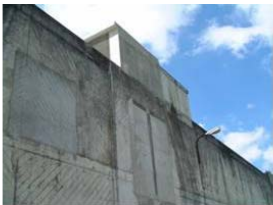
Figura 8 – Alterações no exterior da conduta de ventilação
