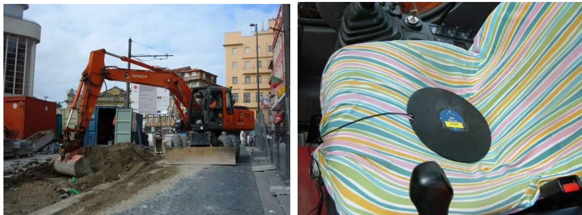
Figura 6 – Exemplo de medição das vibrações transmitidas ao corpo inteiro numa giratória.
