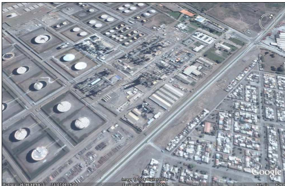
Figura 1. Situación Refinería Bio-Bio ENAP S.A.
