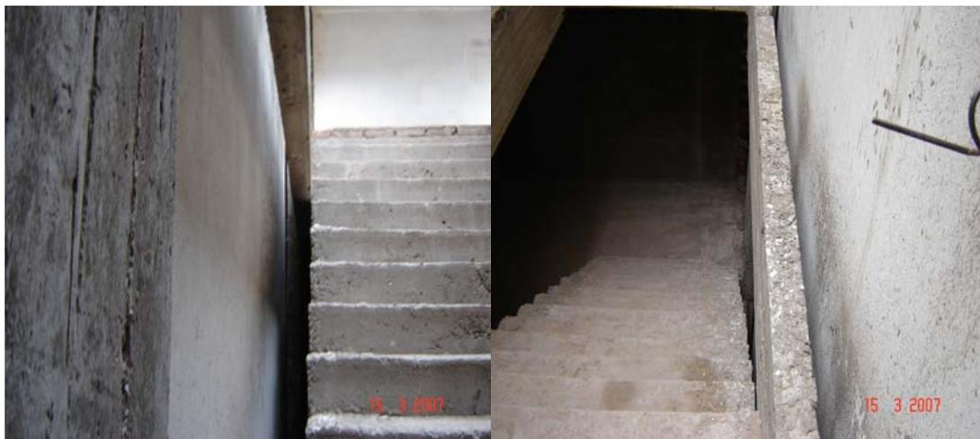
**Foto 15, 16, 17 y 18.** Vistas de la desvinculación de los elementos constructivos de H°A°
