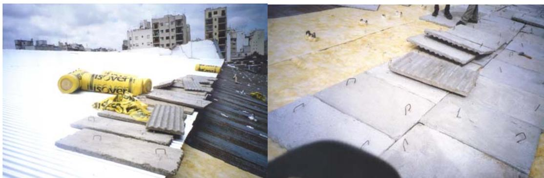
**Figura 6.** Fotos 5 y 6. Montaje cubierta lana de vidrio entre chapa y placas H°A°
