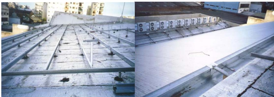
**Figura 7.** Fotos 7 y 8. Montaje cubierta lana de vidrio antes de chapa exterior
